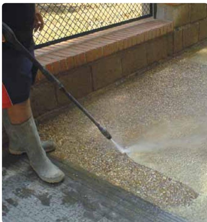
Le pavimentazioni architettoniche in ghiaietto lavato sono gradevoli esteticamente, durevoli nel tempo ed economicamente molto interessanti, in quanto non necessitano di manutenzione. L'effetto ghiaia a vista garantisce un effetto totalmente naturale della pavimentazione; le resistenze meccaniche e le proprietà antisdrucchio lo rendono ideale per la realizzazione di piazze, marciapiedi, rampe, piscine, vialetti di giardini, ecc.
